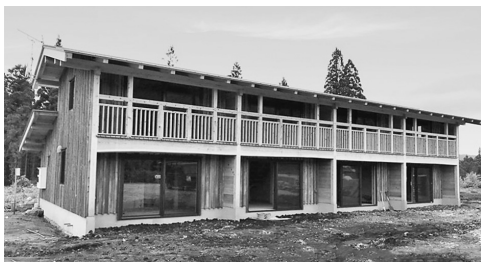
▲木造建築の伝統工法「板倉工法」を採用
